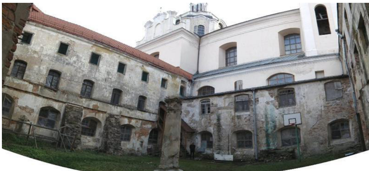
2 pav. Vilniaus dominikonų vienuolyno statinių ansamblio vakarinis vidinis kiemas - kluatras iš šiaurės - vakarų pusės
