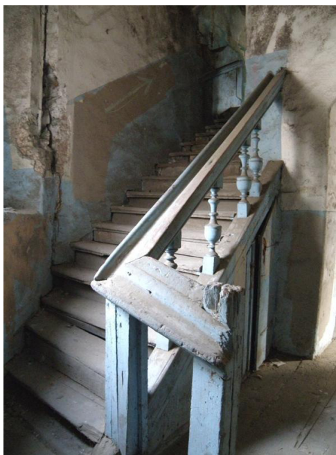
3.7 pav. Rytinio korpuso antro aukšto laiptai į trečią aukštą (patalpa Nr. 50) ( Kultūros vertybių... 2014 )
