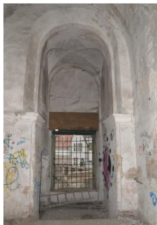
3.13 pav. Vakarinio korpuso antro aukšto laiptinės patalpa Nr. 45 ( Kultūros vertybių... 2014 )
